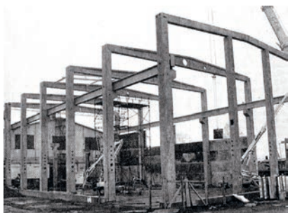
Här byggs stommen till den nya fabrikshallen
